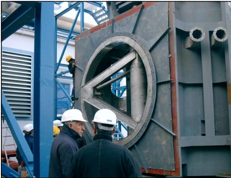
Für den Transport wurde der DIVERTER mehrteilig ausgeführt. Der Zusammenbau erfolgt unter Aufsicht unseres Supervisors Hand in Hand mit der Projektleitung des Kunden auf der Baustelle.
