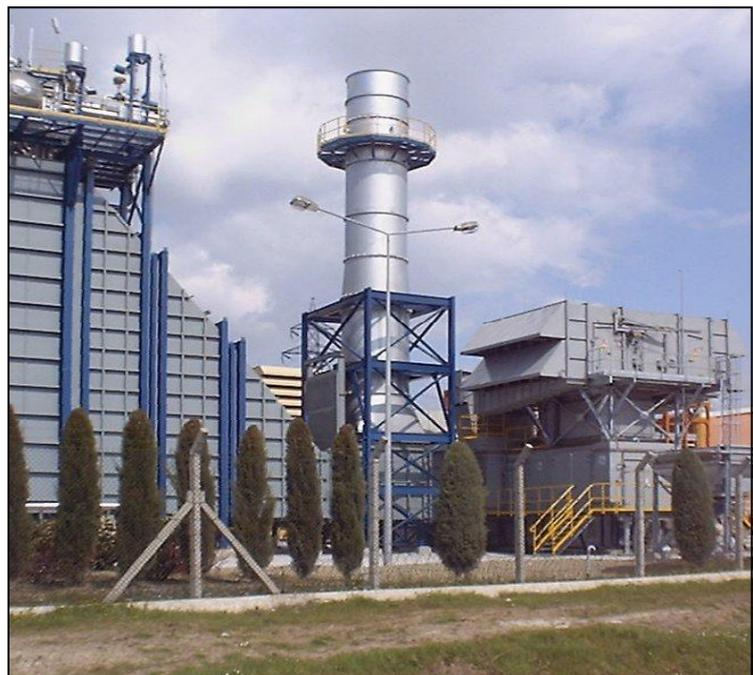
Das nebenstehende Bild zeigt das komplette Bypass- System zwischen Gasturbine und Dampferzeuger.
