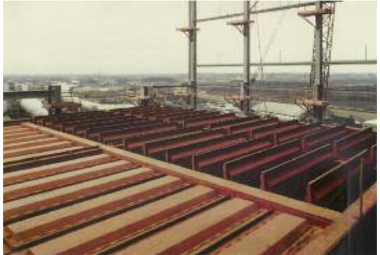
Das Bild oben zeigt eine **Absperrklappe für den DeNOx-Reaktor des STEAG-Kraftwerkes Herne 4**. Mit einer Nennweite von 16.000 x 17.000 mm ist sie bis heute die größte Absperrklappe der Welt.
